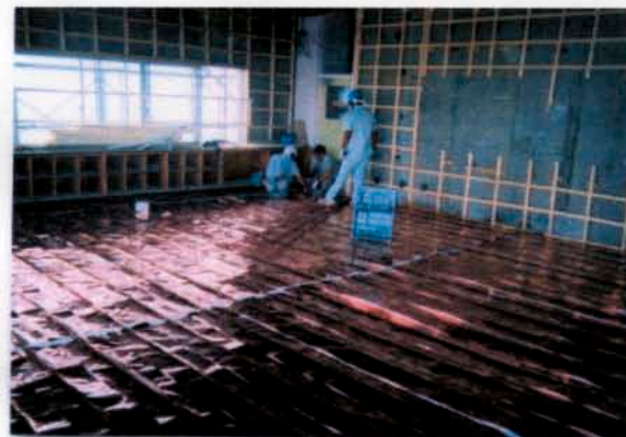
とこだんパネル敷設
