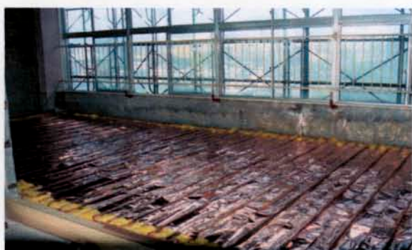
とこだんパネル敷設
