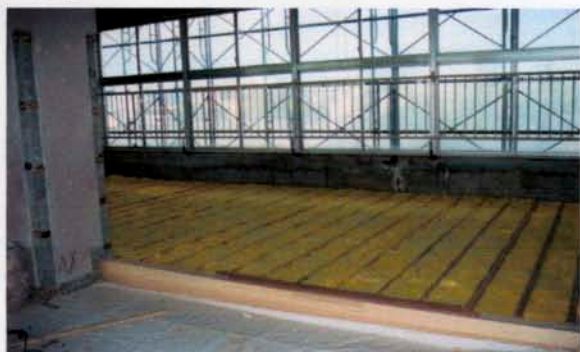
とこだんパネル敷設前
